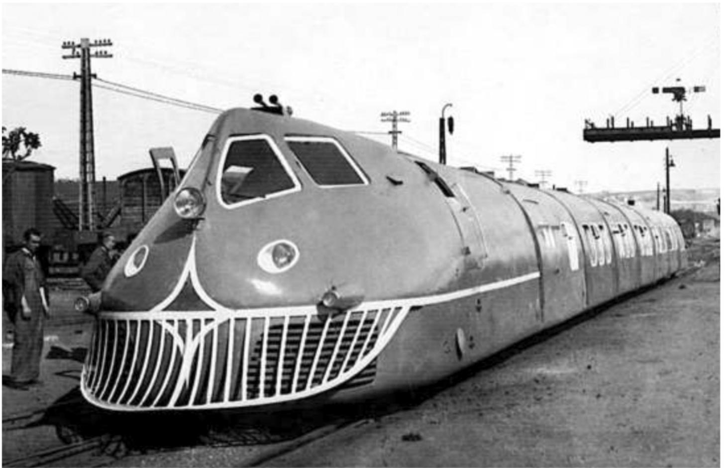
La prima breve sperimentale formazione fu sviluppata rapidamente nel 1944 per testare la funzionalità, il convoglio consisteva in un totale di sette corte vetture di circa 4,44 metri collegate tra loro utilizzando lo stesso principio del banco di prova triangolare; in tal modo ogni singola vettura si sarebbe comportata dinamicamente come una roulotte al traino di una vettura.
