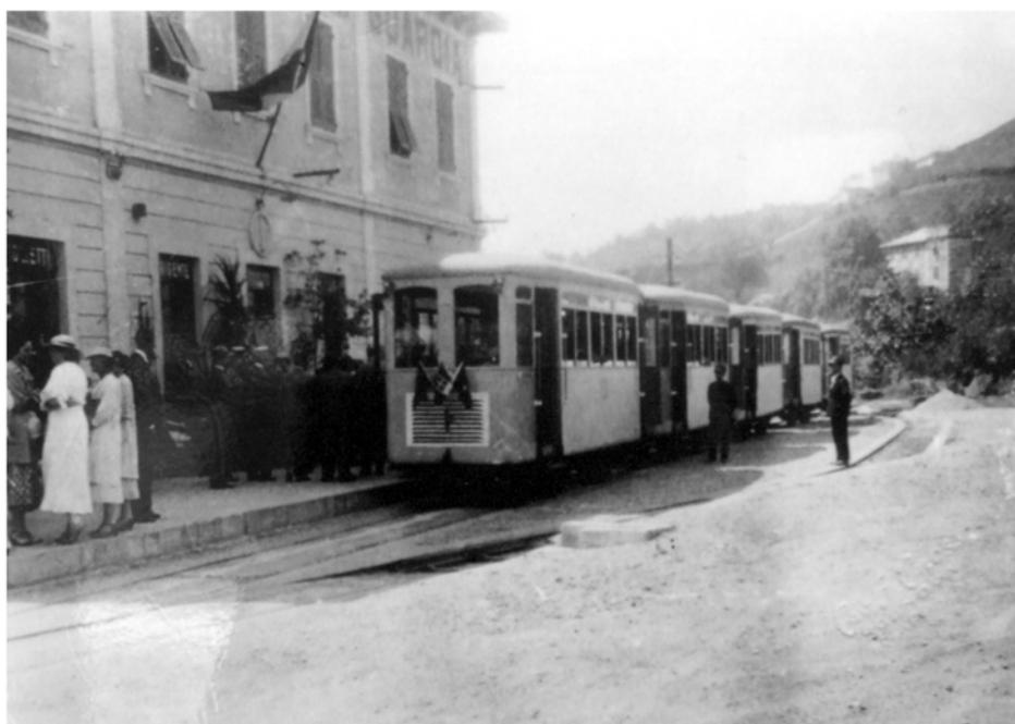
Tutte le vetture erano dotate di un unico respingente centrale e di un sistema di aggancio simile a quello utilizzato dai tram.
