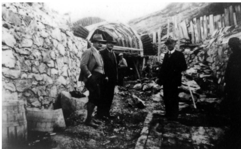
**Qui accanto: fasi della costruzione del tracciato della guidovia e delle opere d'arte; si può osservare la linea di corsa costituita da binari che saranno in seguito affiancati dalle piste in cemento per il rotolamento delle gomme.**
